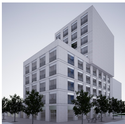
Bytový dům Praha Háje
